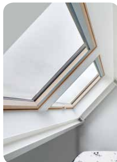
Passiefwoning in Sint-Pieters-Leeuw, gebouwd in 2013, FTT U6 superisolerende FAKRO dakvensters.
