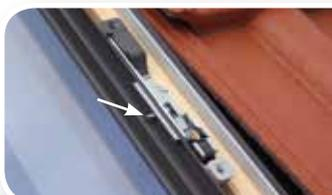
La fenêtre de toit **FAKRO** est équipée d'un système de blocage spécial qui empêche que le vitrage puisse être facilement retiré. Un brevet a été demandé pour cette innovation. (Sur les autres fenêtres de toit, le verre laminé peut être retiré en environ 2 minutes en dévissant les profilés de fixation).
