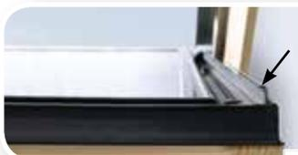
Les fenêtres de toit de la classe Profi présentent un **joint d'étanchéité supplémentaire**, qui assure une étanchéité supérieure en cas de conditions climatiques extrêmes. Ce joint d'étanchéité améliore aussi l'acoustique des fenêtres de toit, en particulier en cas de pluie.
